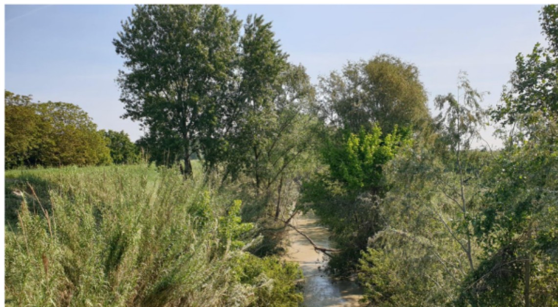
In alto, l'argine del Lamone su via Fratelli Bandiera prima e dopo il ripristino della rottura. Sopra, gli alberi presenti nell'alveo del fiume dal ponte dell'Albergone a Boncellino
